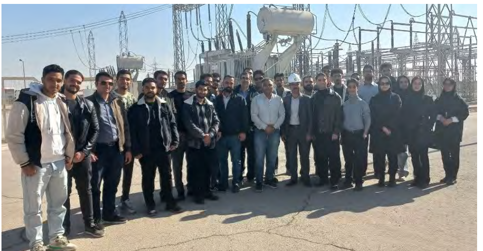
بازدید دانشجویان مهندسی برق از پست ۲۳۰ اردکان
