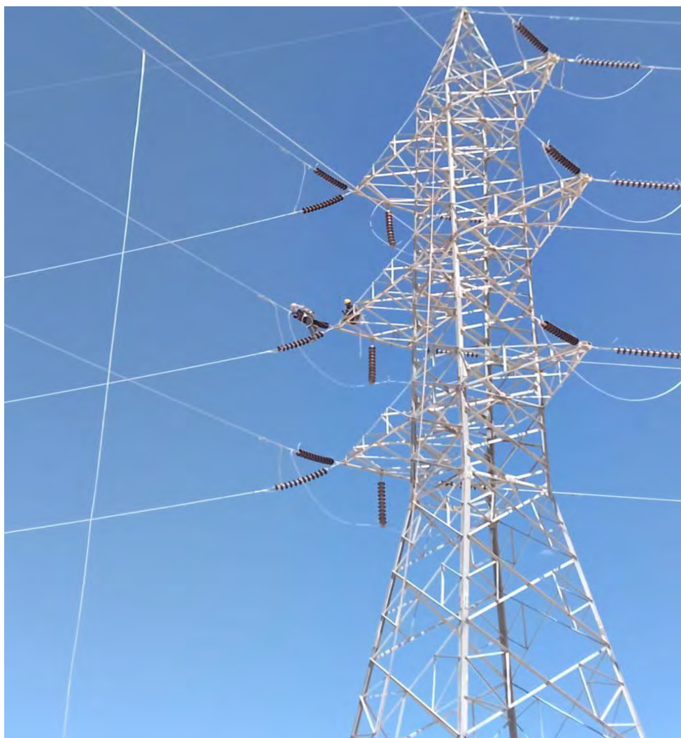
ایثار و مهارت نیروی های خط در نصب تی کلمپ روی خط فوق توزیع منطقه ابرکوه
