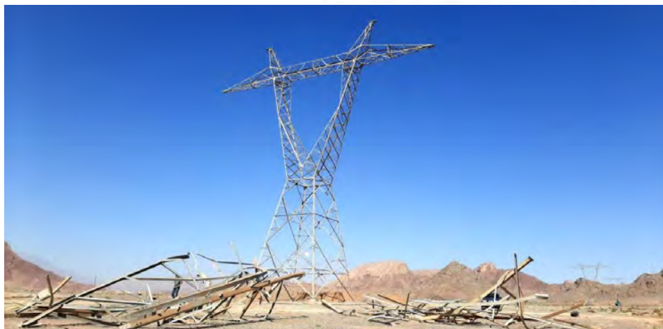
تعمیر و بازسازی برج آسیب دیده در جنگ رمضان با تلاش و تخصص نیروهای فنی
